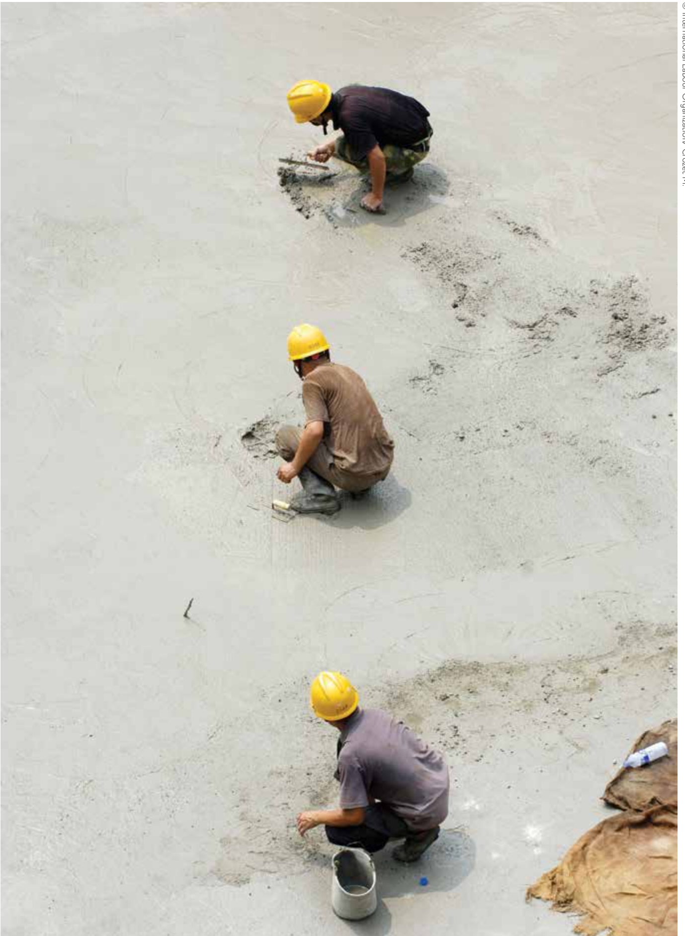
Murere på en byggeplass, Chengdu, Kina.
